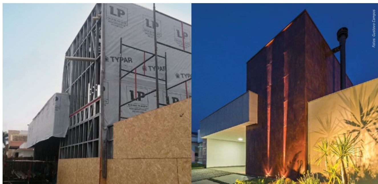
Estrutura - Light Steel Framing
