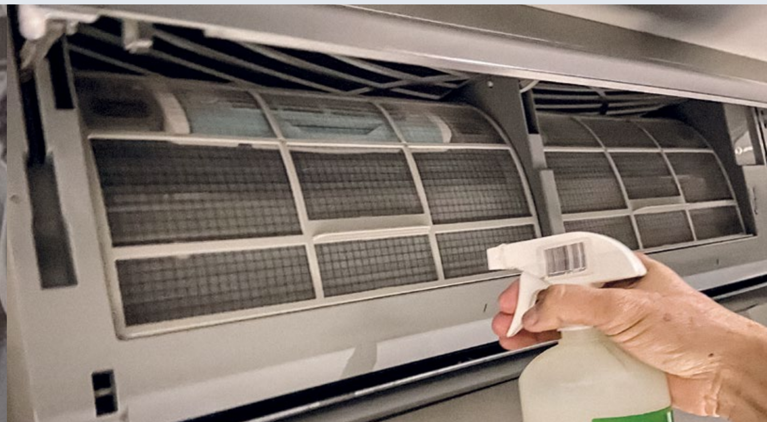
Processo de higienização de aparelho split. Fonte: autor.
